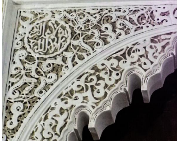
لوحة (١٥) : الجامع الكبير بتازة : التوريقات المعرقة كأرضية للتوريقات المسننة بإحدى بنيقتي عقد مدخل مصلى الجنائز .
